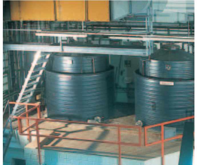
Chemikalienlagerstation zur automatischen Befüllung der Dosierbehälter. Die Chemikalienanlieferung erfolgt über ein Befüllsystem an der Gebäudeaußenwand.
