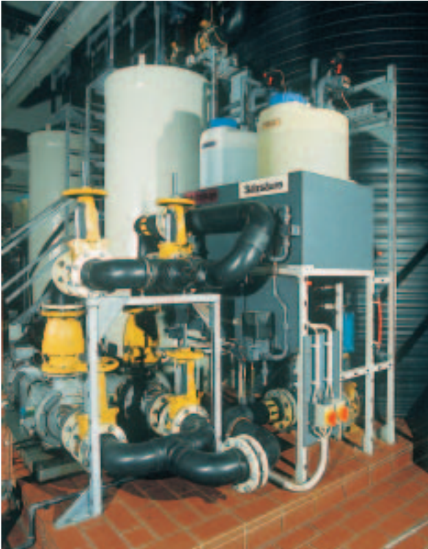
Neutralisationsreaktor mit Dosierbehältern und Förderpumpe.
