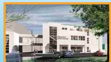
Außenfassade des Neubaus
