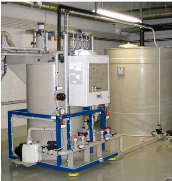
hameln pharmaceuticals GmbH: Neutro-Fix 3 mit Vorlagebehälter, Leistung max. 3000 l/h.
