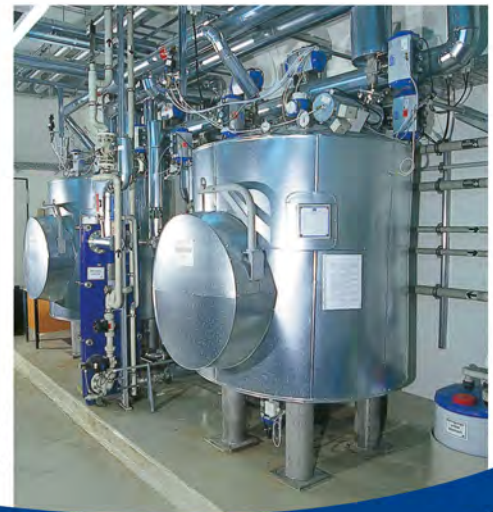
Chemisches Veterinär- und Lebensmittelunter- suchungsamt, Fellbach: im Wechsel betriebene Sterilisatoren
