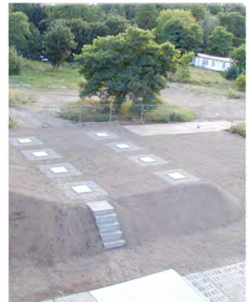
Helios Klinik, Buch (Berlin), 4 x 40 m 3 Stapelbehälter als Erdtanks
