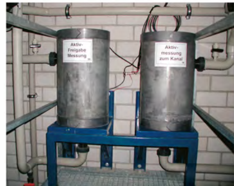
Aktivitätsmessanlage mit Bleiabschirmung zur Überwachung des Kanalabgangs
