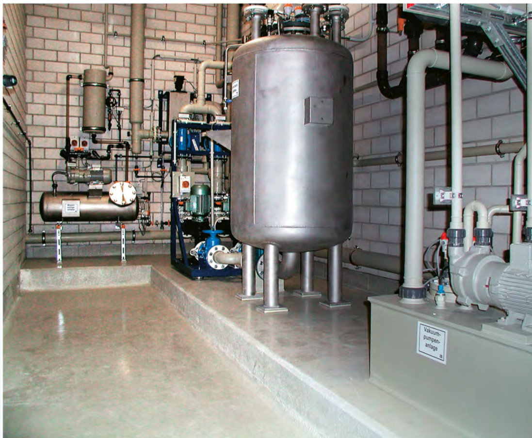
Vakuumsation mit Fäkalienzerkleinerungspumpen: vakuumfester Druckbehälter mit nachgeschalteten Zerkleinerungspumpen, Be- und Entlüftungsstation der Abklingbehälter einschließlich Filtereinheit
