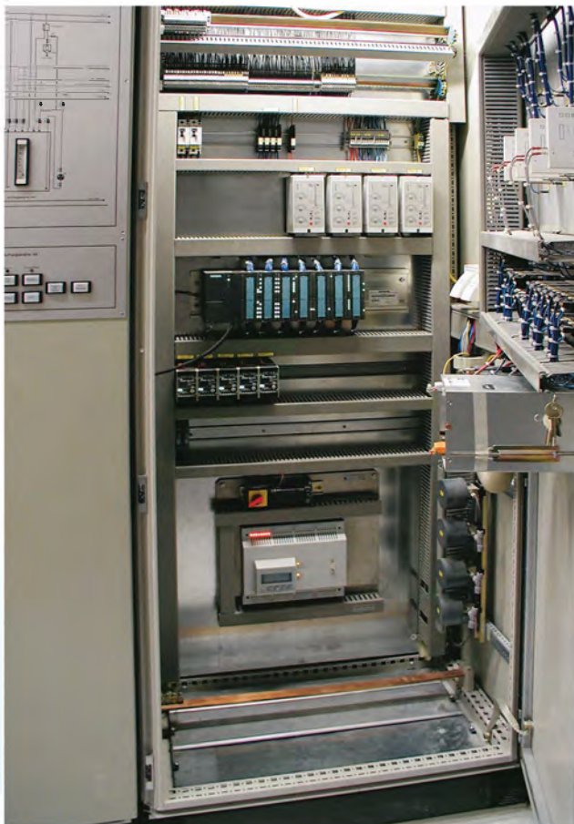
SPS der Firma Siemens und Überwachungseinheit für Frischwasserverbrauch der Patienten
