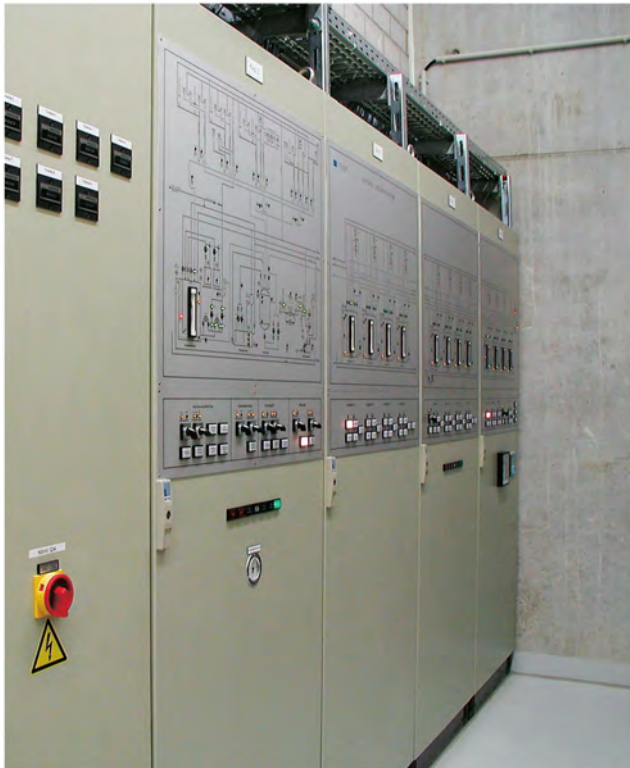
Zentraler Schalt- und Steuerschrank mit eingebauter SPS, an den Türen montierte Fließbilder mit Leuchtdioden, Füllstandsmessungen und Bedienelementen
