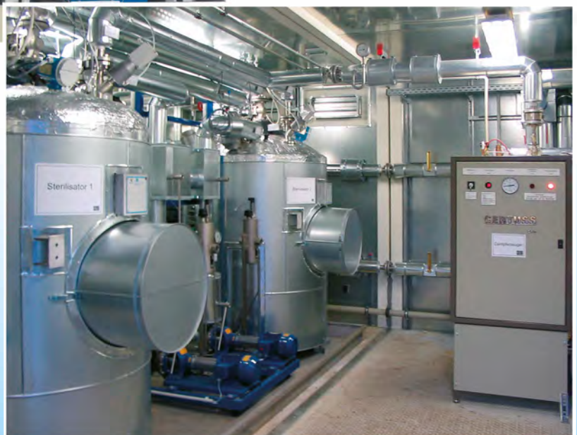
SteriFix C 500 (Containerbauweise mit Dampferzeuger) im Amt für Lebensmittelüber- wachungs- und Verbraucherschutz, Rostock
