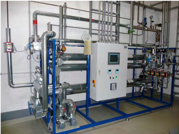
SteriFix E 250, Leistung 250 l / h, 134°C 2 min. Verweilzeit, Phyton Biotech GmbH, Ahrensburg
