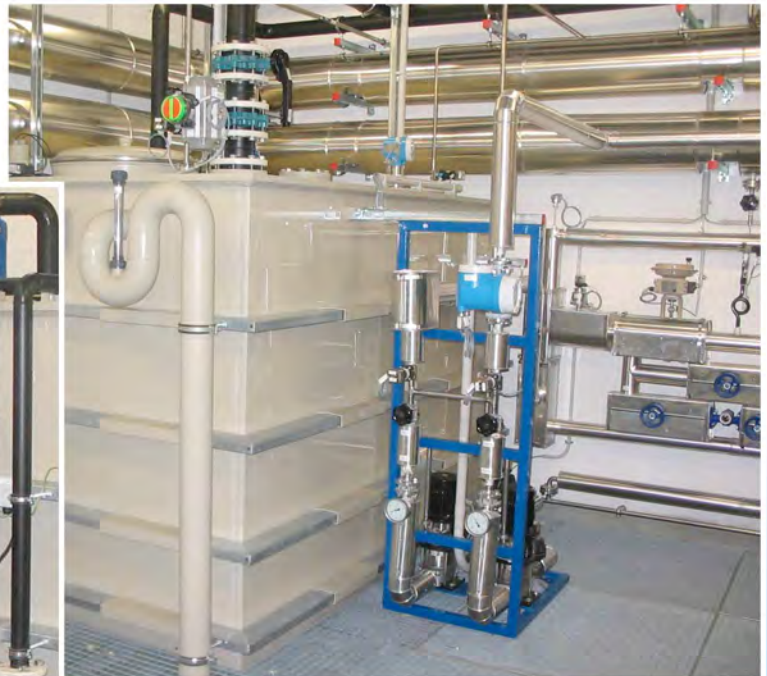
Pufferbehälter 12m 3 mit Verweilstufe u. Kühlung
