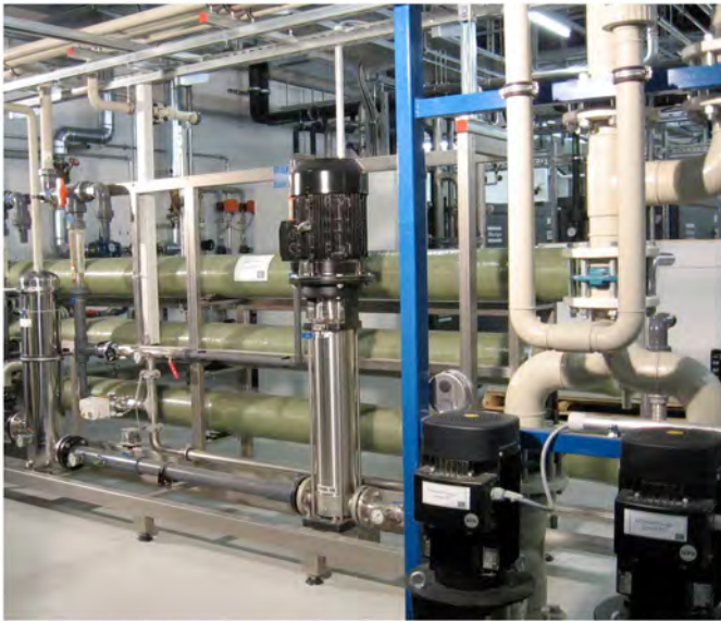
Bosch AG, Abstadt: Umkehrosmose mit Konzentrataufbereitung
