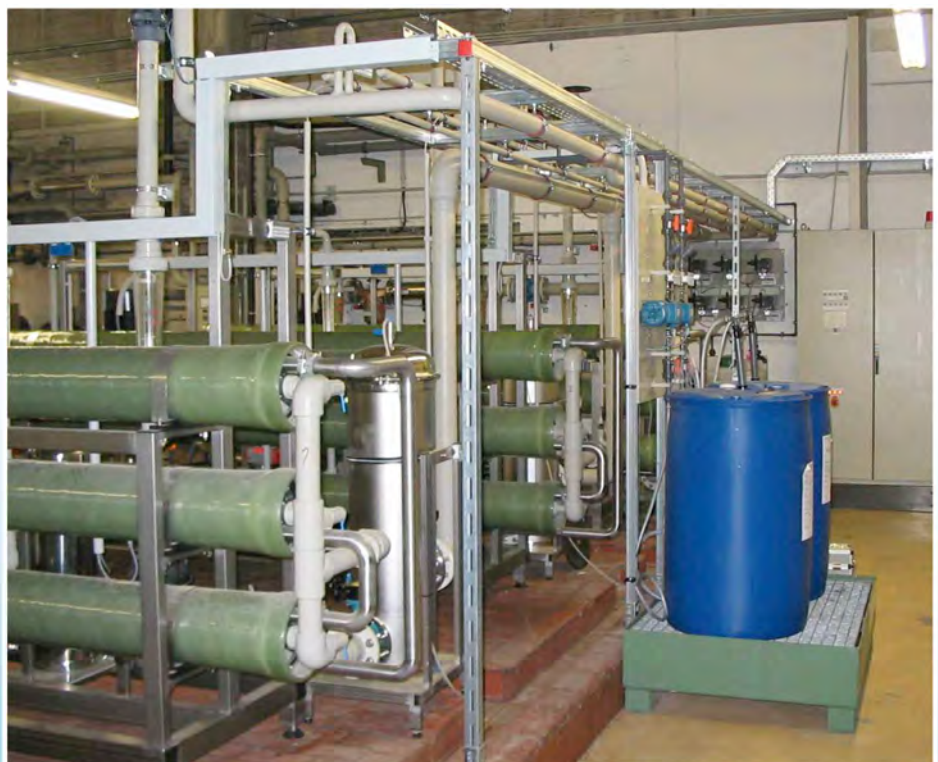
Bild oben und rechts: Kesselspeisewasseraufbereitung der Universität Mainz, Umkehrosmose 3 x 10 m³/h, permeatgestuft mit vorgeschalteter Härtestabilisierungsdosierung
