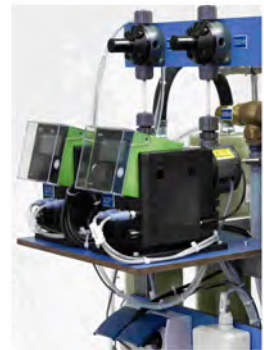
Bild unten: Regelbare Dosierpumpen für Antiscaling
